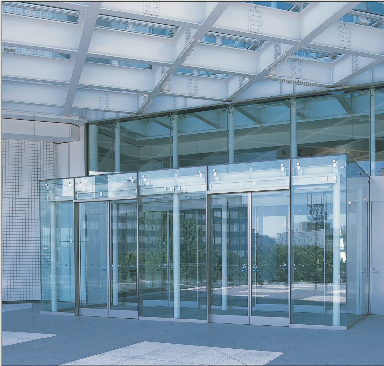
晴海 トリトン ホール棟
