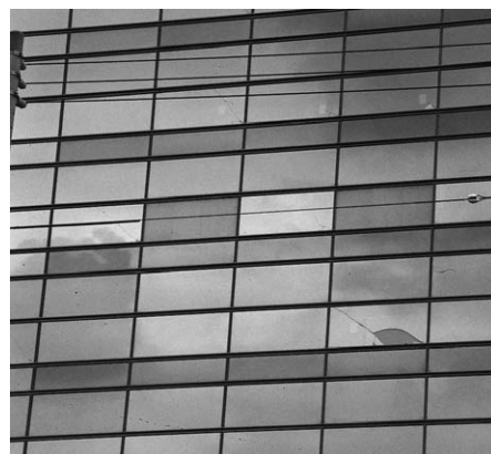
▲ビル外壁破壊、ガラスは2枚のみ破損(弾性シーリング材)
