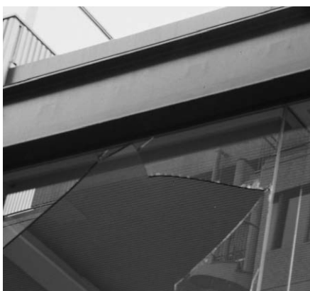
▲フレームとガラスが接触、ガラスは落下
