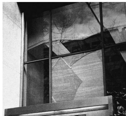
▲スチールサッシにパテ施工、ガラス破損
