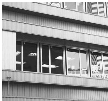
▲スチールサッシにパテ施工、ガラス破損
