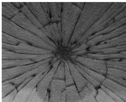
フロート板ガラスの割れパターン
